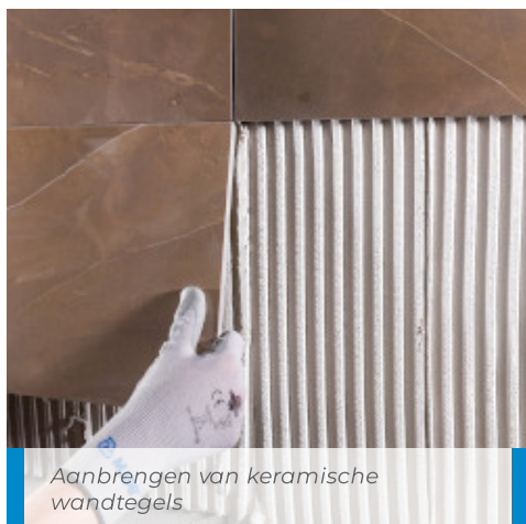
Aanbrengen van tegels met houteffect op een met Mapelastic waterdicht gemaakte ondergrond
